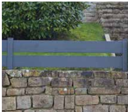
Clôture ajourée. Lames larges de 160 mm.
