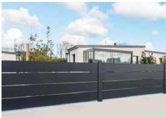
Clôture ajourée. Lames larges de 160 mm.
